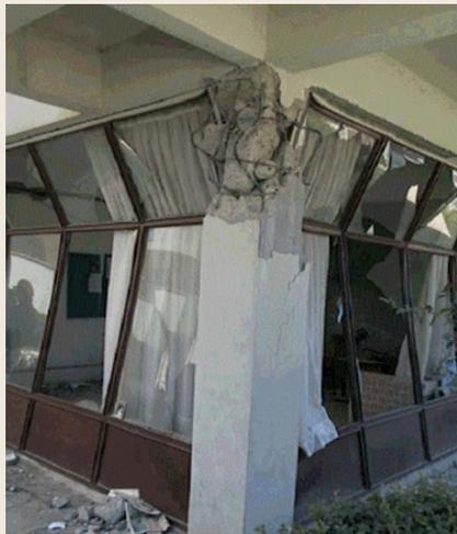
Figura 5.5h Fallas por cortante-flexocompresión en columnas de concreto.
