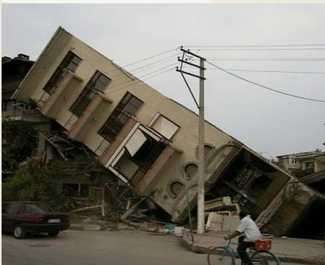
Figura 5.5e Falla rotacional de la cimentación de un edificio sensiblemente esbelto en la dirección corta.
