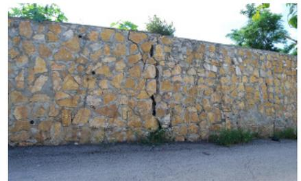
d) Agrietamiento en estructuras en el hombro de un talud.
