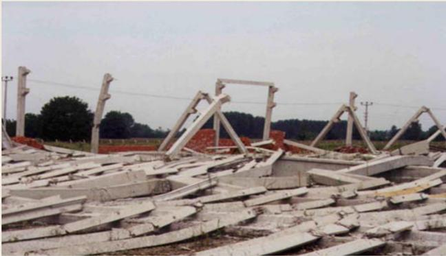
Figura 5.5a Colapso de edificio prefabricado con apoyos (ménsulas) con dimensiones insuficientes para acomodar las demandas de desplazamientos laterales.
