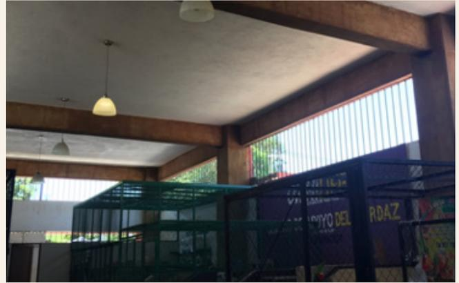
Figura 5.2b Estructura de concreto reforzado sin daño en columnas y vigas: sólo se evidencia agrietamiento y desprendimiento del mortero de acabado a lo largo de la junta vertical entre columnas y muros exteriores.
