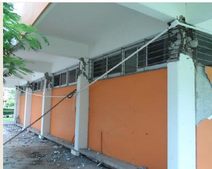
Figura 5.4e Daño severo evidente en columnas (sistema resistente a cargas gravitacionales).
