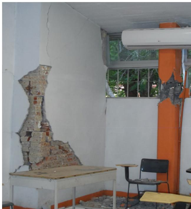
Figura 11.5 Ejemplos de daño en muros divisorios de mampostería de un edificio escolar. Fuente: cortesía del INIFED (2019).
