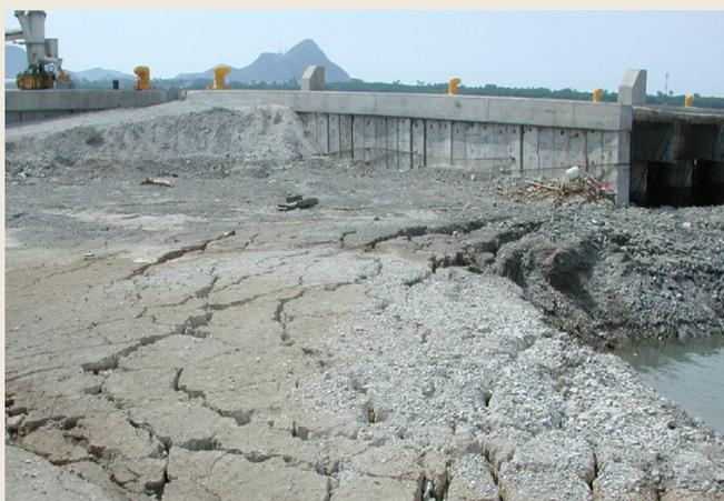
Figura 5.4g Desplazamiento lateral del suelo producido por licuación de arenas (véase las zonas de arena expulsada).
