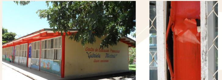
Figura 5.3e Aplastamiento local de una columna de acero producto del efecto de “columna corta”.
