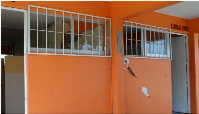
Figura 5.3b Daño moderado por tensión diagonal en un pretil y en columna de concreto.
