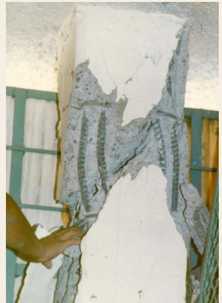
**Figura 3.12** Falla por tensión diagonal en columnas cortas de marcos de concreto.
