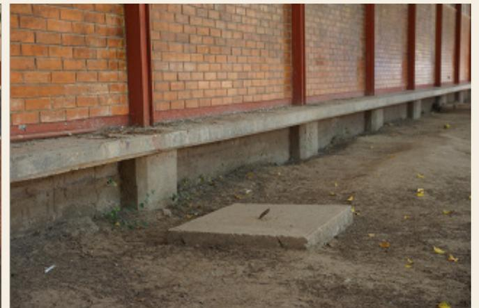
**Figura 3.26** Agrietamiento de dados de concreto de la cimentación de un edificio escolar.
