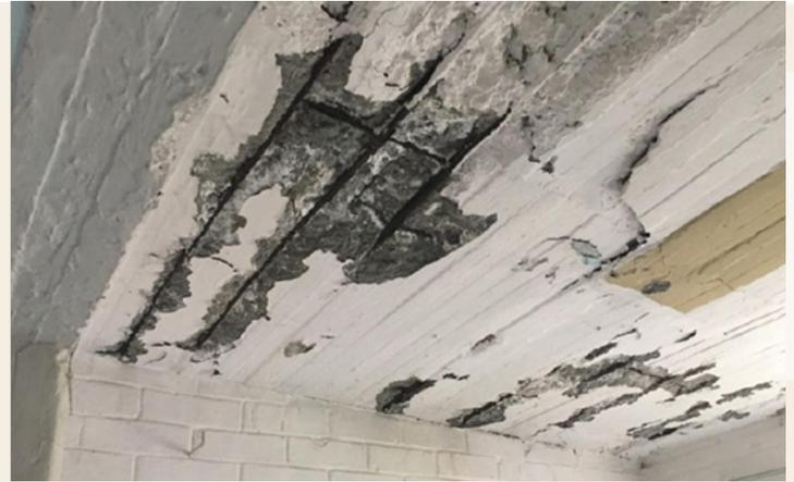
**Figura 3.27** Desprendimiento de concreto en losas debido a corrosión del acero de refuerzo.
