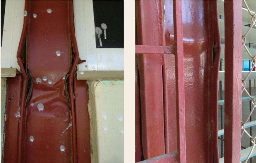
**Figura 3.14** Falla por aplastamiento, con pandeo local de placas y fractura de soldaduras en columnas de acero por el efecto de "columna corta".
