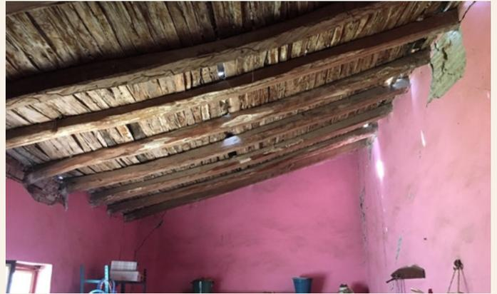
Figura 5.3a Daño moderado en una construcción de adobe, con agrietamiento vertical en esquina y aplastamiento incipiente en el apoyo del techo.
