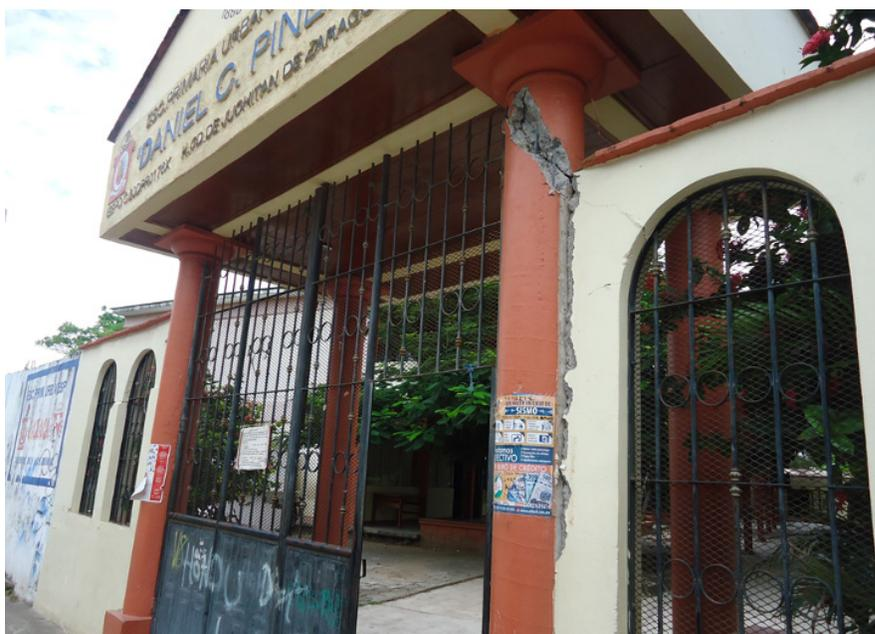
Figura 11.2 Techumbre apoyada en columnas con daño severo. Fuente: cortesía del INIFED (2019).
