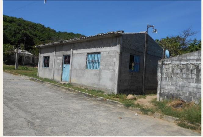
Figura 5.2a Estructuras de mampostería confinada sin daño.
