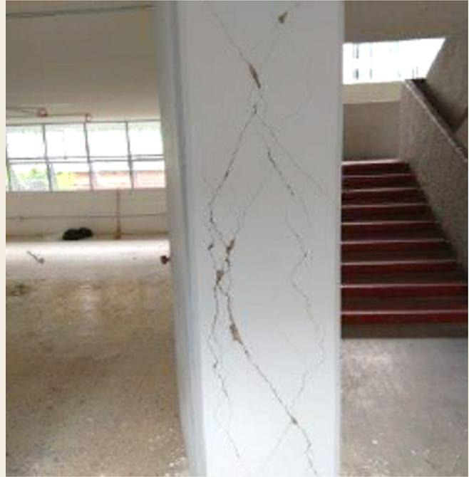
**Figura 3.11** Agrietamiento por tensión diagonal en columna de concreto.
