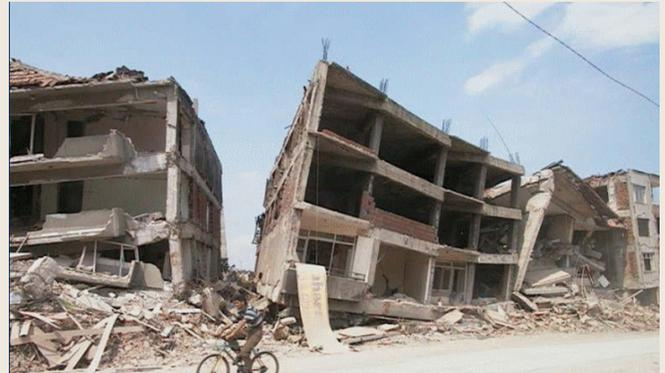
Figura 5.5b Colapsos totales de marcos de concreto reforzado.
