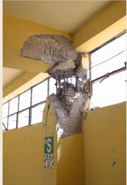
Figura 5.5g Ejemplos de falla de columnas por tensión diagonal por el efecto de "columna corta".
