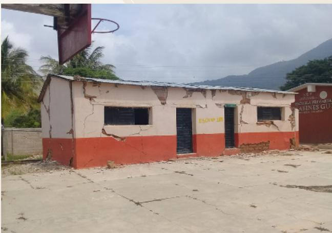
Figura 5.4c Daño severo evidente en estructura de adobe.
