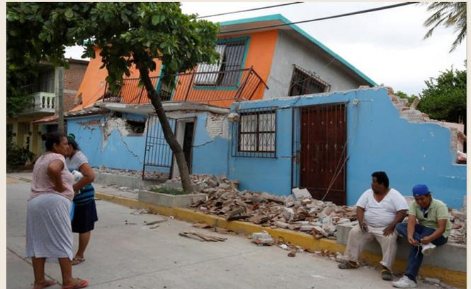
Figura 5.4b Colapso total de un edificio de mampostería.
