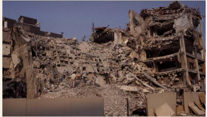
**Figura 3.23** Falla por cortante en conexiones de losas planas con columnas de concreto.
