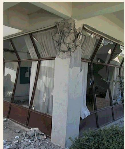
**Figura 3.13** Falla por flexión-tensión diagonal y compresión en el extremo superior de columnas de marcos de concreto.
