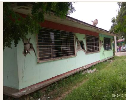
Figura 5.4f Daño severo evidente en muros (sistema resistente a cargas gravitacionales y a fuerzas laterales).
