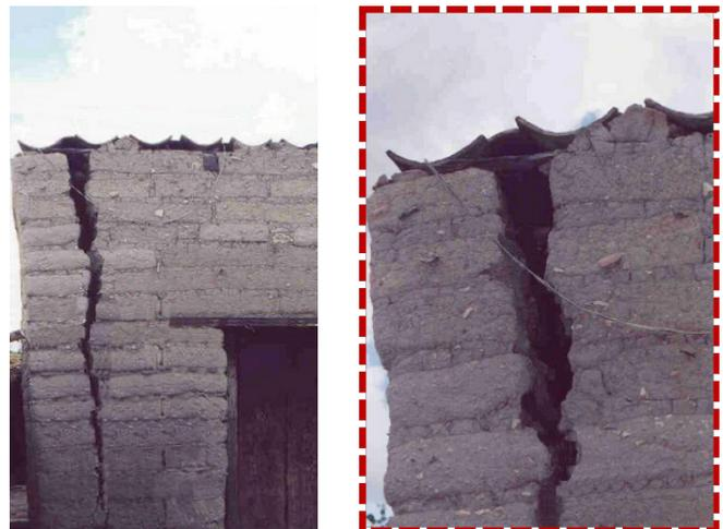
Figura 3.20 Agrietamiento vertical en la intersección de muros de mampostería simple (adobe).
