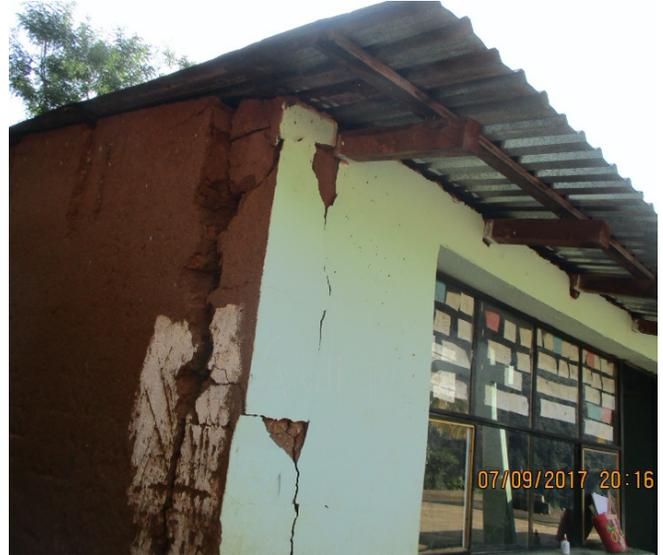
Figura 3.19 Falla por tensión diagonal en muros diafragma de mampostería.
