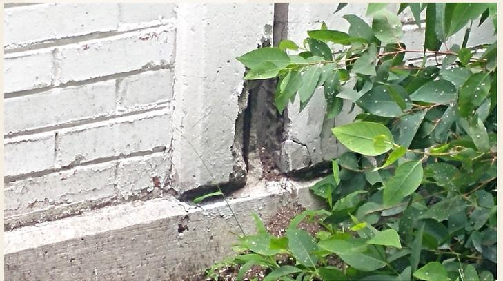
**Figura 3.28** Corrosión del acero de refuerzo vertical en bardas perimetrales.
