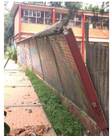
**Figura 3.22** Falla por flexión fuera de plano de bardas de mampostería.
