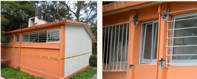
Figura 5.3d Agrietamiento y desconchamiento incipiente en extremos de un par de columnas de concreto.
