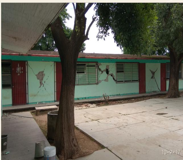
Figura 3.18 Falla por tensión diagonal en muros de mampostería. Fuente: cortesía del INIFED (2019).
