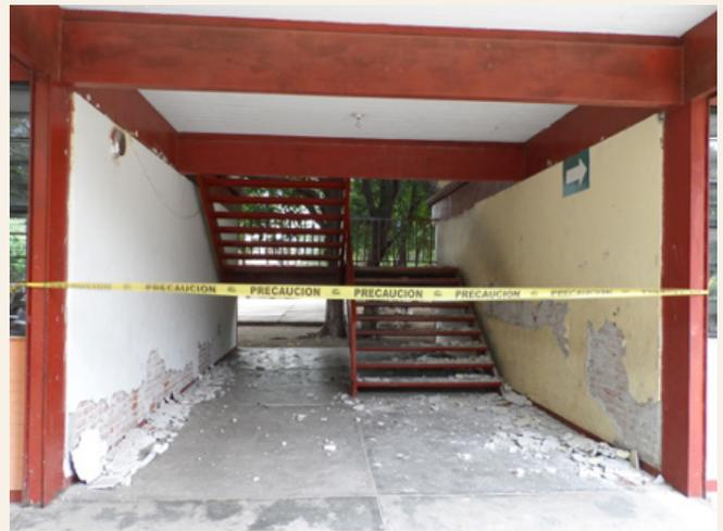
Figura 5.2c Edificio escolar sin daños en elementos resistentes a cargas verticales y a fuerzas laterales; sólo se aprecia desprendimiento del mortero de acabado de algunos muros.
