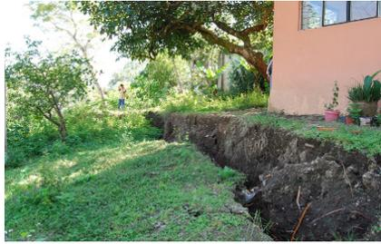
a) Escarpe o escalón en el terreno en la parte alta de un talud.
