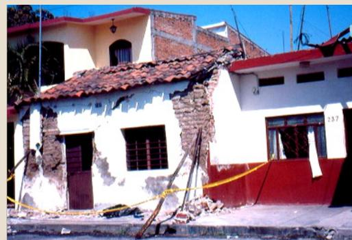
Figura 11.1 Ejemplos de: a) caída de pretil y b) peligro de caída de tejas sueltas. Fuente: archivo personal de Sergio Alcocer (2003) y cortesía del CENAPRED (2019).
