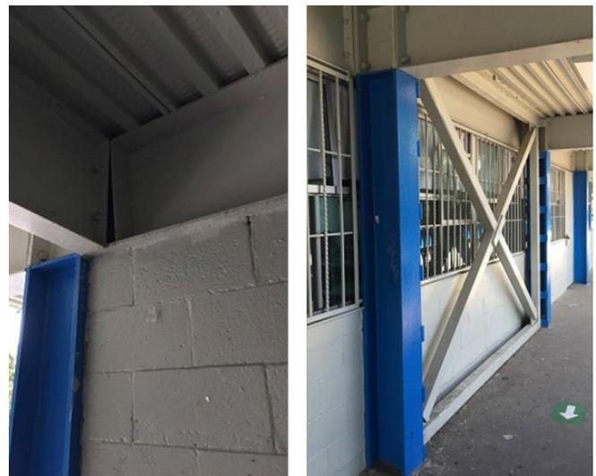
Figura 3.17 Conexiones excéntricas viga-columna en estructuras metálicas.
