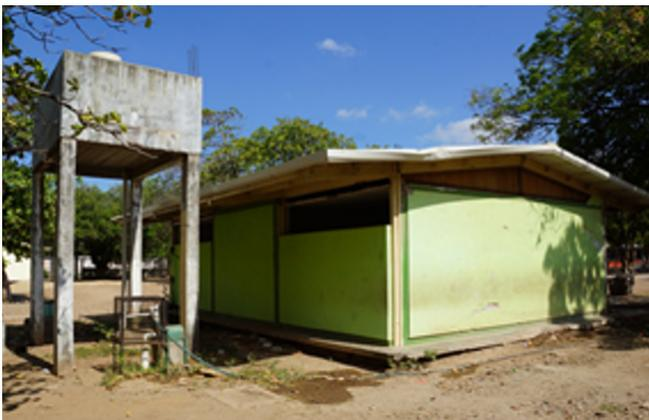
Figura 3.5 Concentración de masa en techos de edificios escolares y depósito de agua en una estructura independiente.
