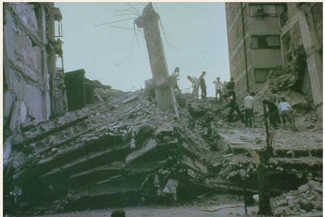
**Figura 3.24** Falla por punzonamiento en losas planas unidas con columnas de concreto.
