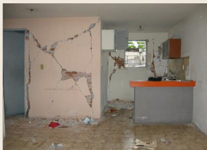
Figura 5.5i Agrietamiento por tensión diagonal en un edificio de mampostería mal confinada.
