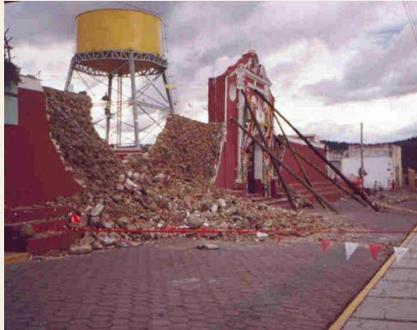
**Figura 3.21** Falla por flexión fuera de plano de muros de mampostería.
