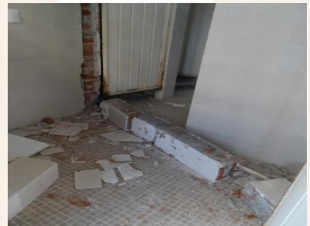
Figura 5.3f Daños en acabados, cancelería y otros elementos no estructurales.
