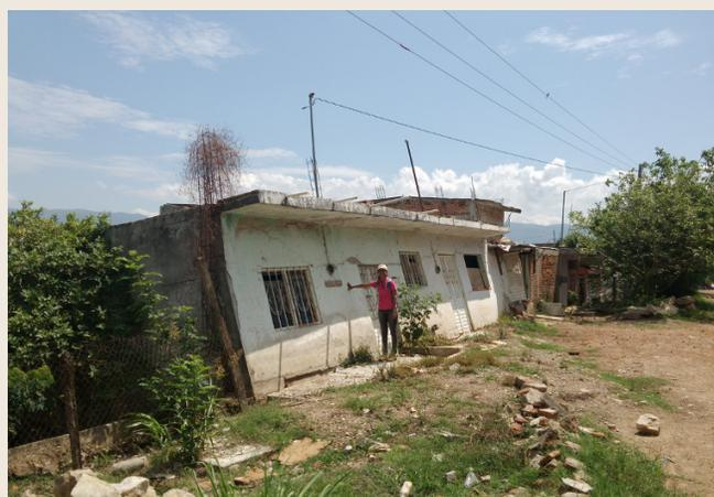
Figura 5.4h Edificación en el hombro de un talud inestable.
