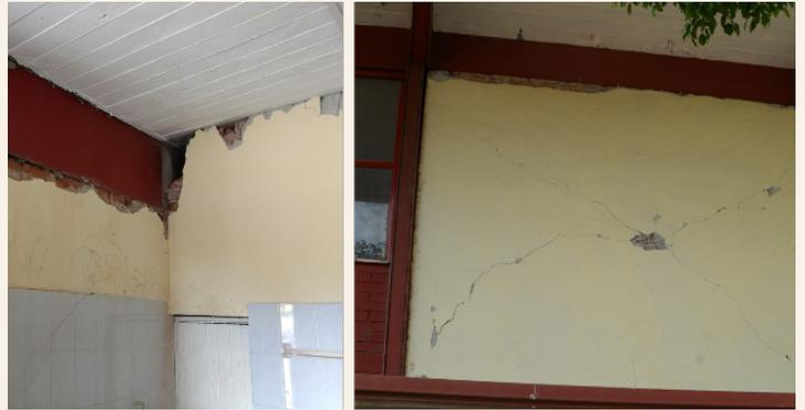
Figura 5.3c Agrietamiento ligero a moderado en muros diafragma.
