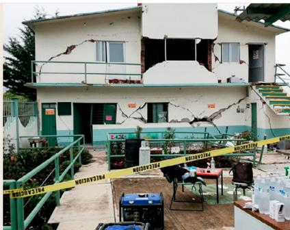
Figura 5.4d Daño severo evidente en edificio de mampostería mal confinada.
