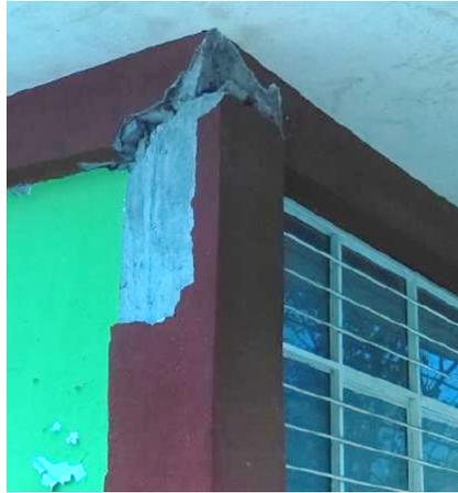
Figura 3.15 Agrietamiento por cortante en uniones viga-columna en marcos de concreto con muros diafragma.
