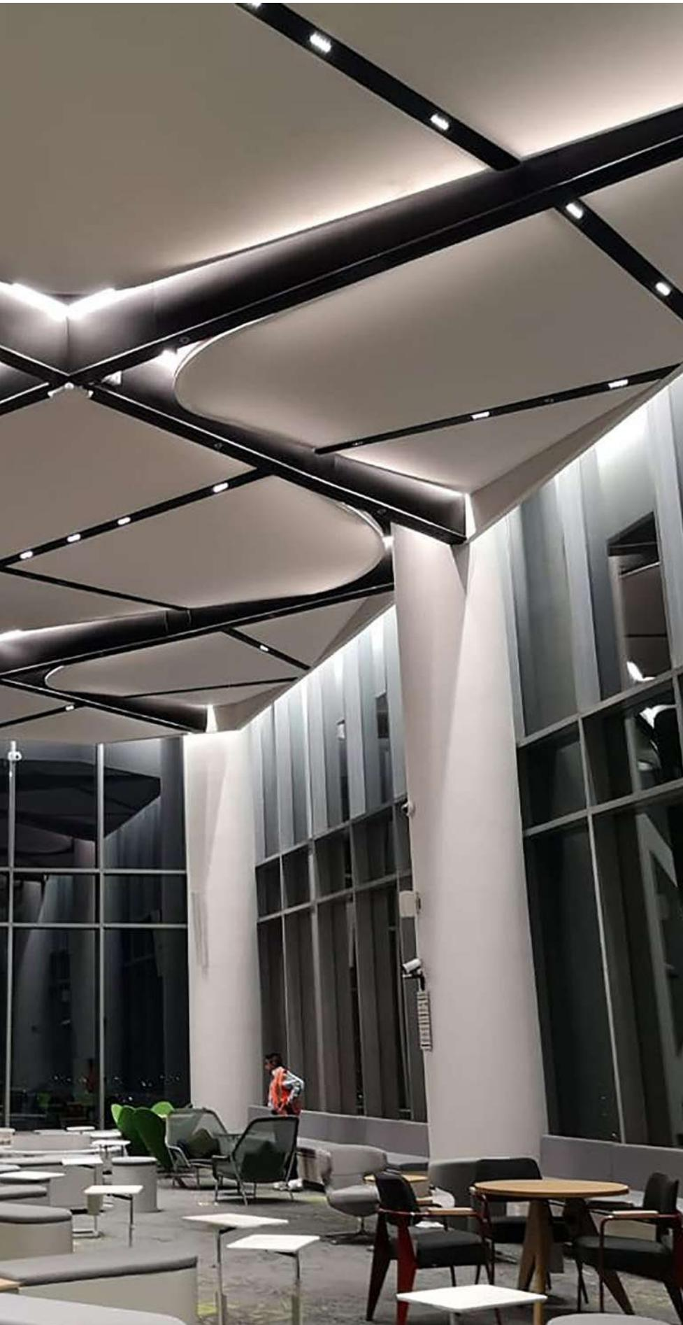
**LA ATENUACIÓN** del sistema lleva un protocolo 0-10V lo que permite una atenuación más exacta de la intensidad lumínica del luminario. Para esto requiere un cableado de control a través de cada una de las fuentes de atenuación al sistema de control (tablero).
